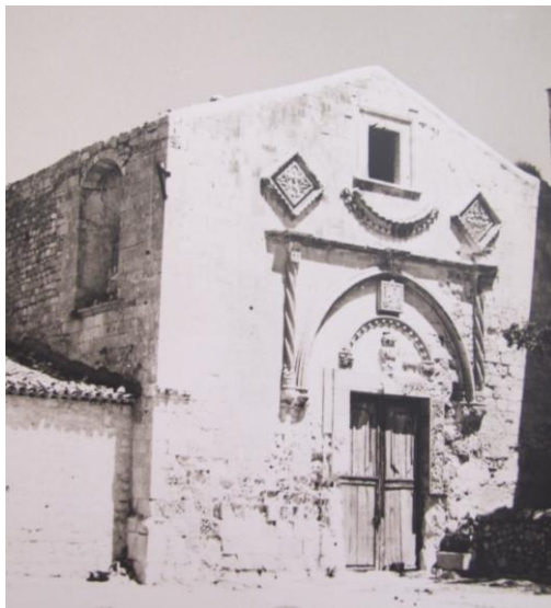
Chiesa del Convento della Croce
